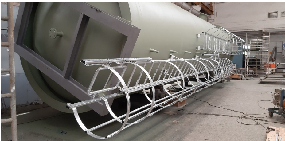
W trakcie montażu drabinek obsługowych
